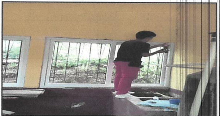
Foto 4: Sustitución de ventanas de madera por metal mas vidrio
